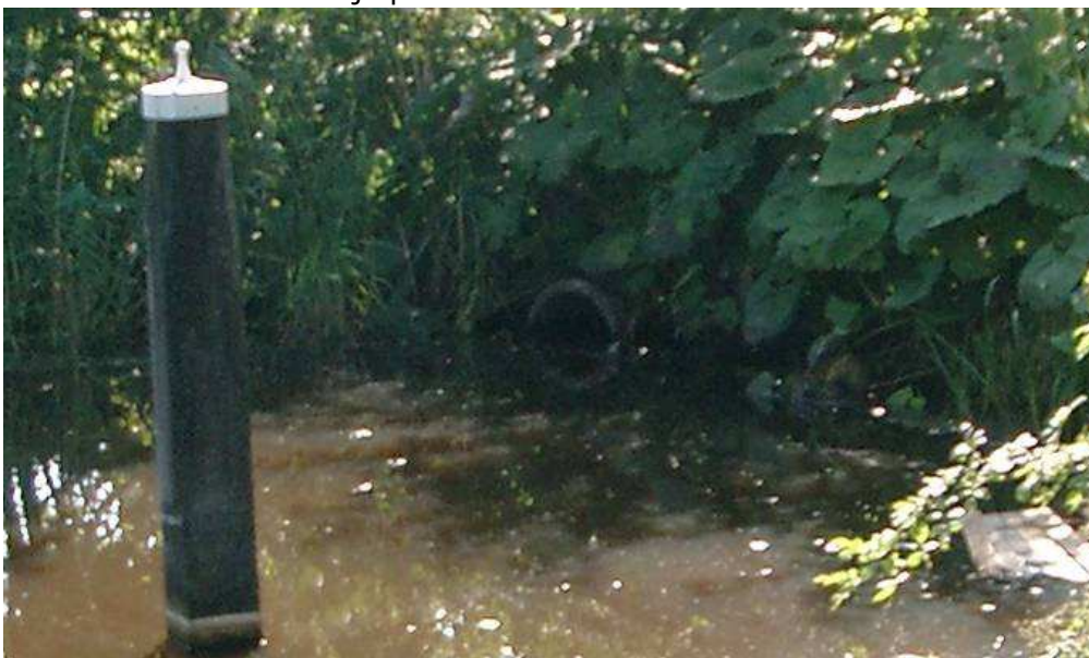
De buisdiameter is te klein voor een goede vismigratie. Ook ligt de buis niet diep genoeg.
